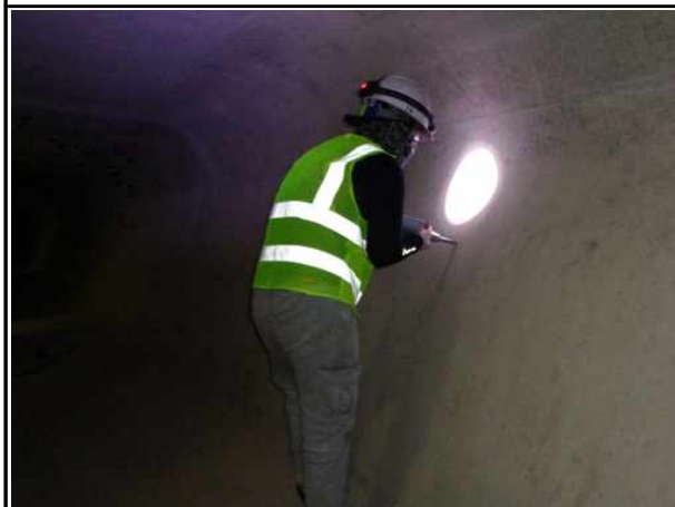
거더내부 외관조사 및 비파괴시험
