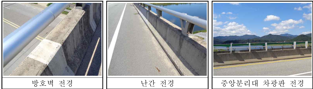
【그림 3.6】 방호벽/중앙분리대 현황
