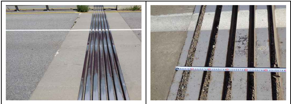
【그림 3.24】 신축이음장치 유간측정 조사전경
