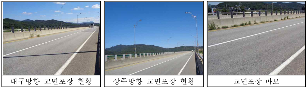
【그림 3.3】 교면포장 현황
