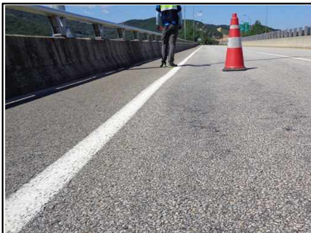
교량상부 외관조사(3인 1조, 도보조사)
